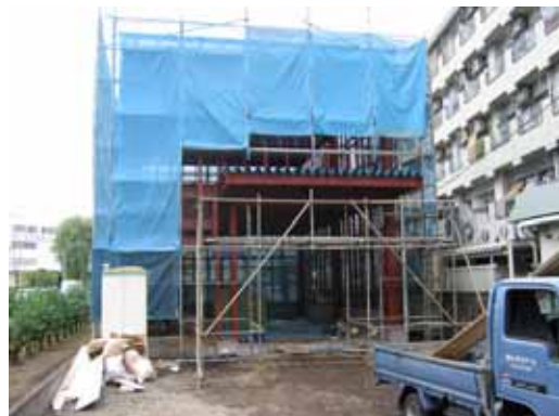
建設状況 H18.9.4
